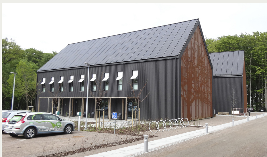
Plusenergikontoret Väla Gård har 455 kvm solceller på sydväst delen av sadeltaken vilka producerar lika mycket el som kontoret använder på årsbasis till fastighetsenergi och verksamhetsenergi.
